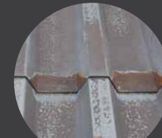
Hochdruckreiniger (200 bar rotierender Strahlkopf), um alles an losen und abblätterndem Stahl zu entfernen. Entfernen des Rostes mit einer St2 mechanischen oder manuellen Vorbereitung. Jegliche schlecht korrodierten Bleche werden ersetzt. Jegliche korrodierte Enden, die zu dünn sind, werden zurückgeschnitten, bis man auf festes Material trifft.
