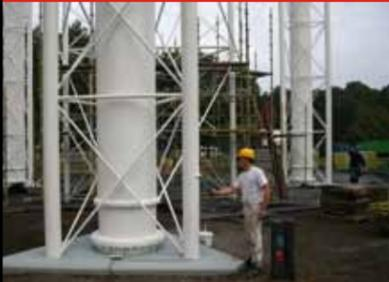
Noxydizing Technologie angewendet bei Wassertanks Bilder: Eli Smans
